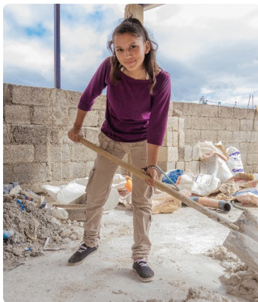
Albañilería del proyecto Munijoven, en noviembre de 2019. Fotografía: PNUD Guatemala.
